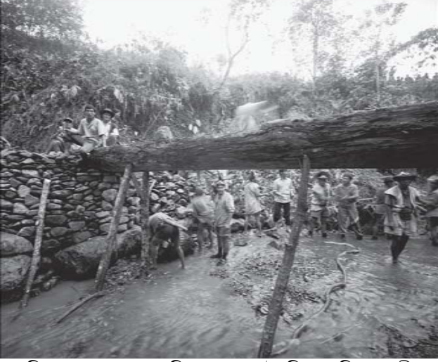
চিত্র ১১: ২০০২ সালে সিমঙ-এ সেতু তৈরি—আদি গ্রামবাসীরা সার বেঁধে পাথর বসচ্ছে। চিত্রগ্রাহক—মাইকেল আরম টার।
